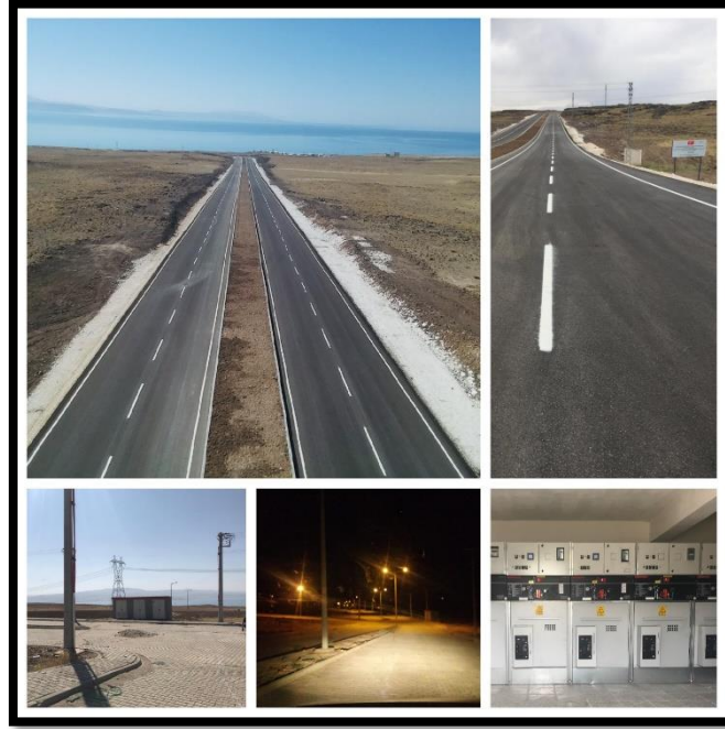
Resim 67: Van Erciş Organize Sanayi Bölgesi Enerji Nakil Hattı ve Yol Altyapısı Projesi
