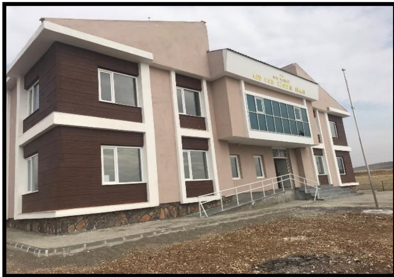
Resim 57: Muş OSB-Muş Organize Sanayi Bölgesi Altyapı ve Yatırım Ortamını Geliştirme Projesi
