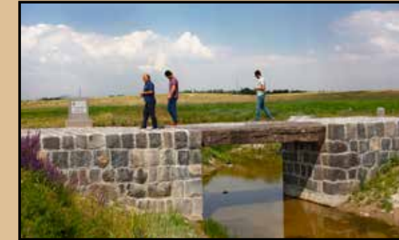
Malazgirt Kız Köprüsü
